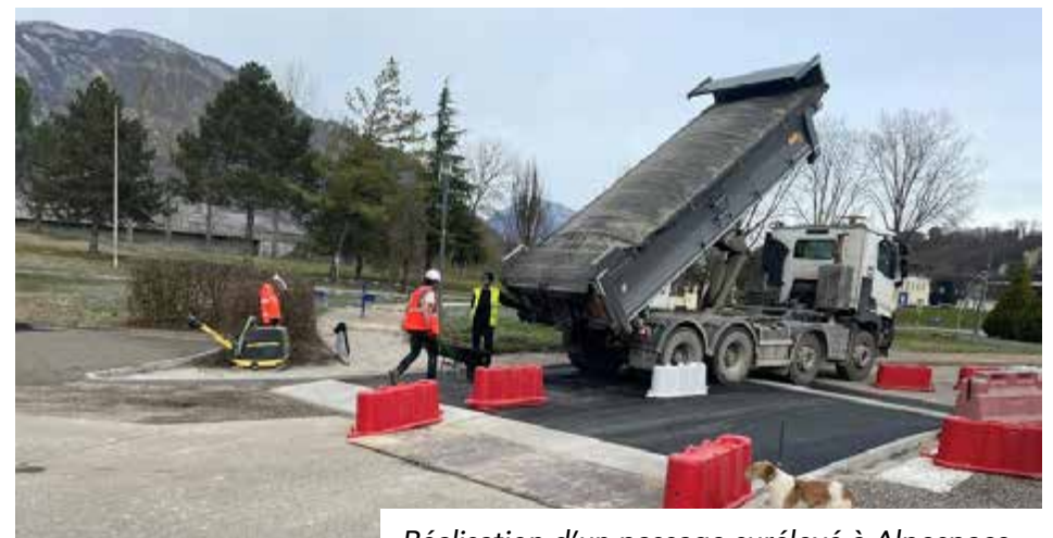
Réalisation d'un passage surélevé à Alpespace
