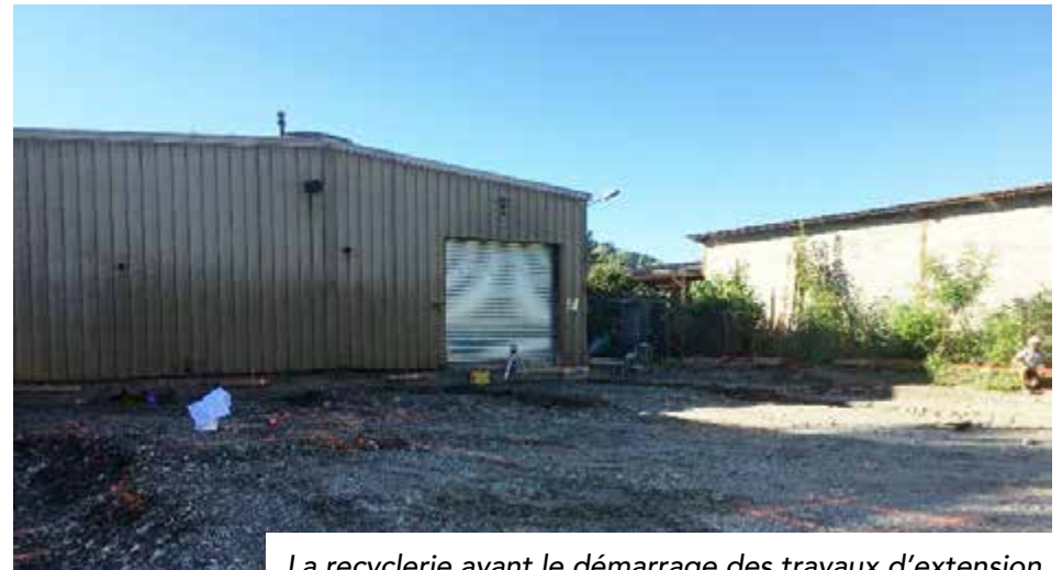
La recyclerie avant le démarrage des travaux d'extension
