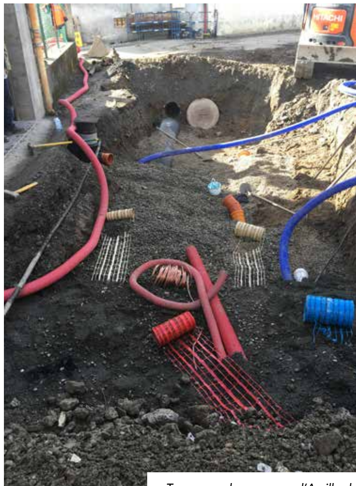
Travaux sur la commune d'Arvillard
