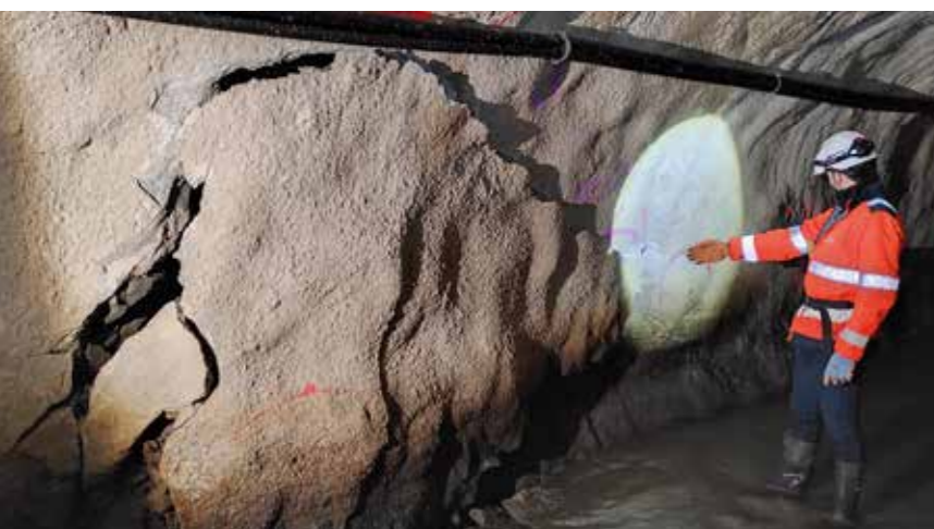
Visite technique de la galerie de rejet au Rhône
