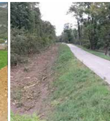
Déboisement avant travaux
