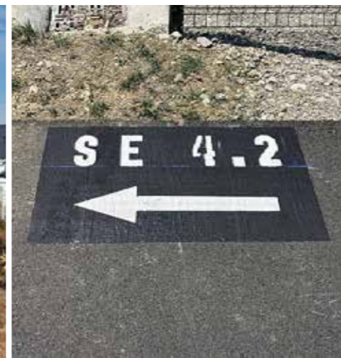
Marquage des PK sur les digues
