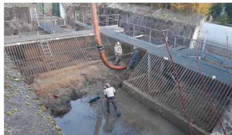
Curage du bassin de Chevaline (Aix-les-Bains)
