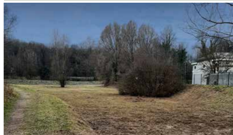
Fauche du déversoir de la Leysse (UDEP du Bourget-du-lac)
